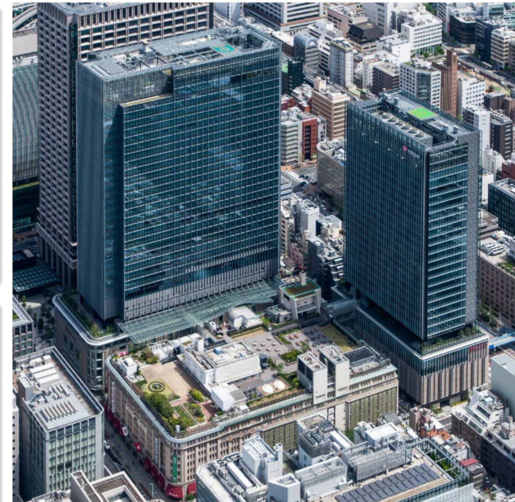
約6000㎡の屋上緑地を設置
